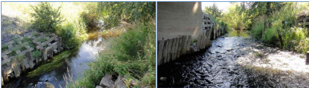
Hanhijoen ylittävän sillan alapuoli ennen sillan uusimista ja kalataloudellista kunnostusta.
